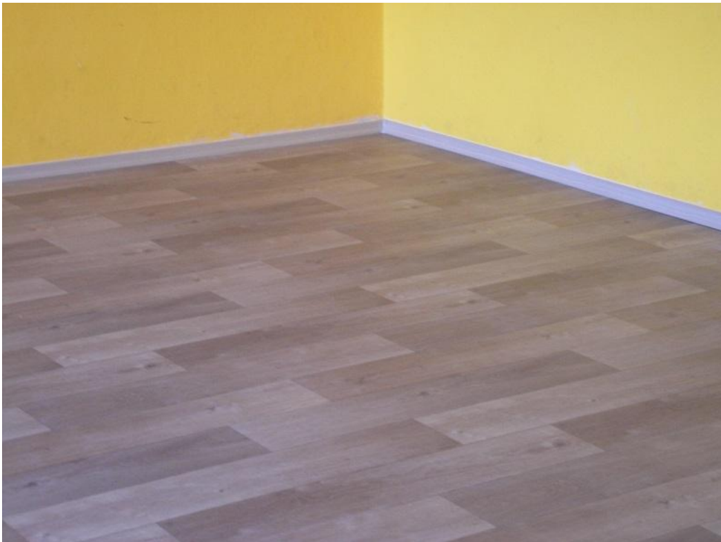
Rekonstrukce podlahy ve 4. třídě
