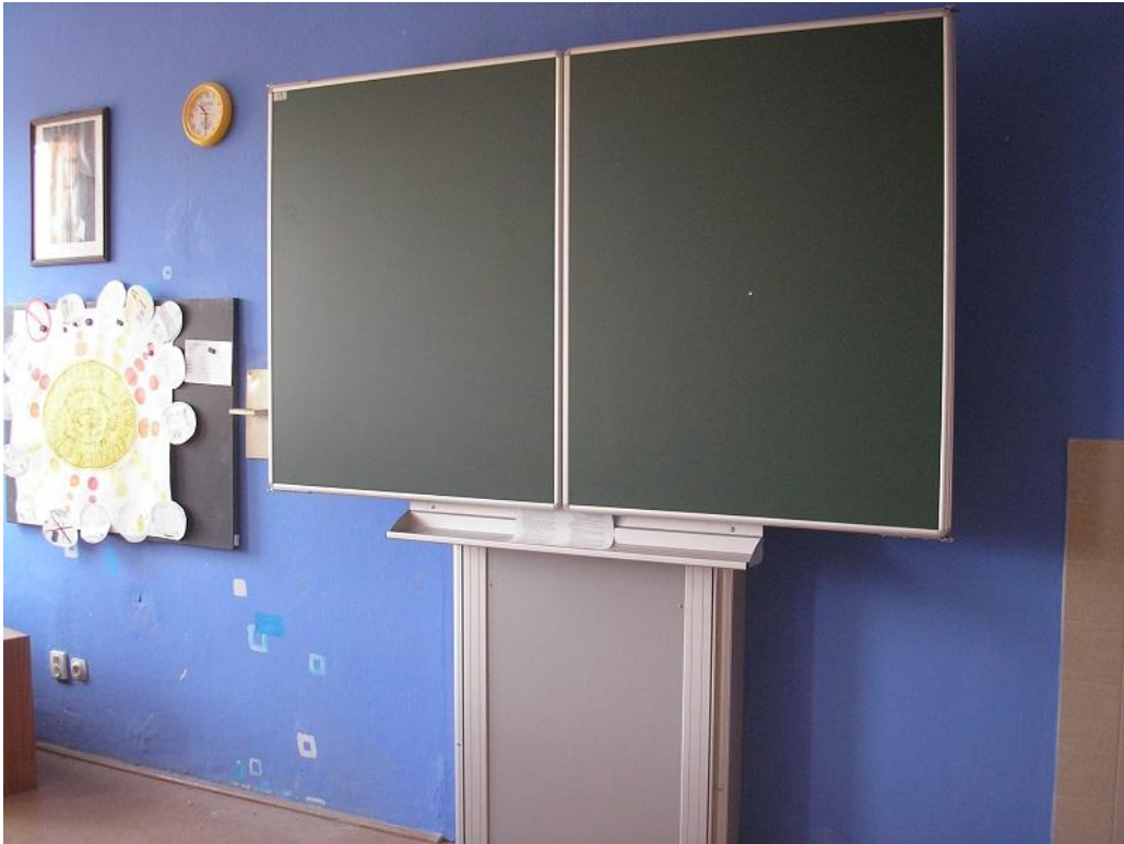
Výměna tabulí na II. stupni
